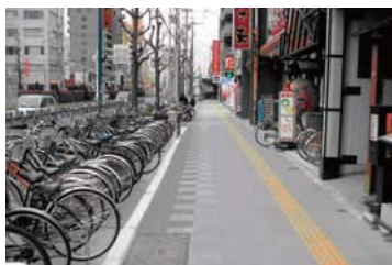
地下鉄黒川駅周辺の駐輪場(整備後)
